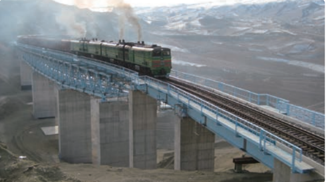
上路連続トラスの海外鉄道橋
