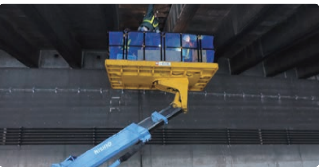
覆道点検の作業風景
