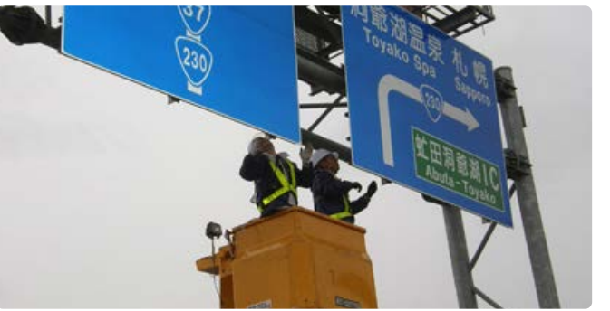
付属物(道路標識)の点検風景
