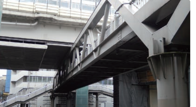
桁下空間の厳しい跨道トラス人道橋
