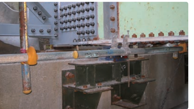
桁橋の補修(部材交換)
