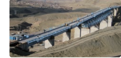
海外トラス橋
