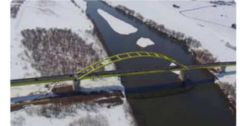
鋼床版連続箱桁橋 + ニールセンローゼ橋
