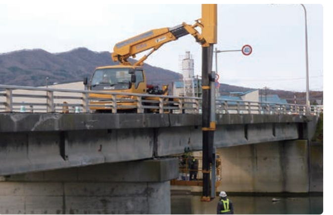
橋梁点検の作業風景
