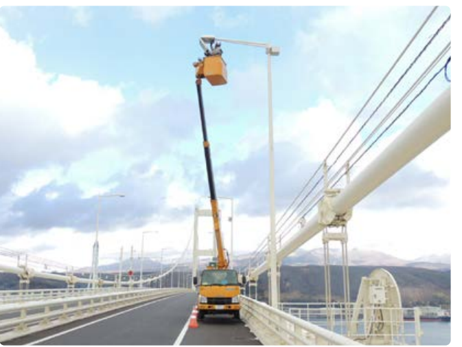
付属物(照明柱)の点検風景
